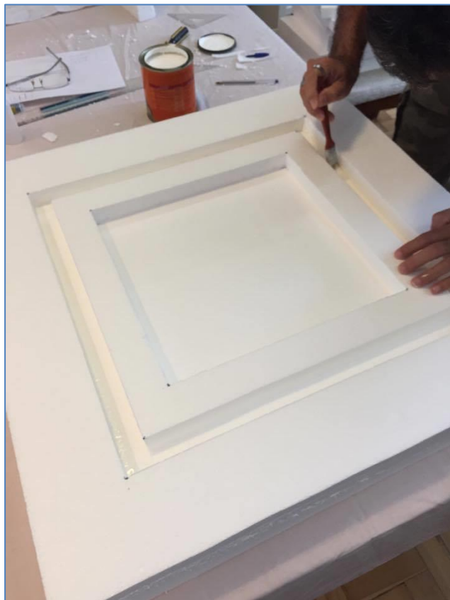
Figura 20: Etapa de construção da base [Fonte Própria]
